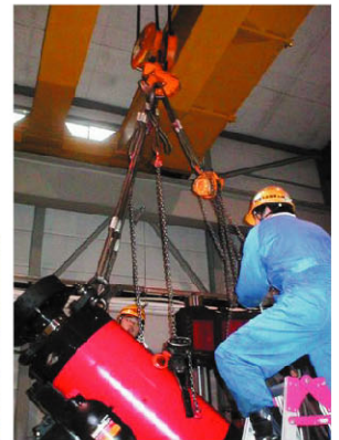
振動試験機設置工事
